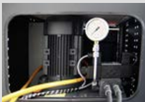
Zweikreis hydraulikaggregat im Schrankunterbau
